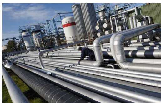
Recubrimientos de tuberías
